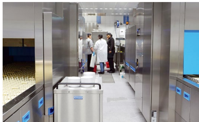
Spülbereich mit sparsamer und dampfbetriebener Spültechnik mit der Bandspülmaschine M-iQ. „Hier wurde große Leistung auf kleinster Fläche geplant“, so Eva Gelhausen.
