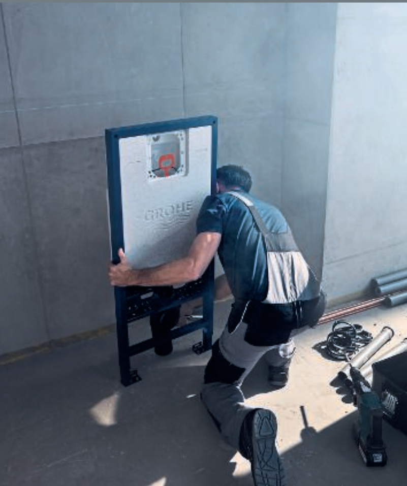
Mit der „Whisper Technologie“ bietet Grohe Schallschutz für Unter-spülkästen an, hier das Installationssystem „Rapid SL“.
