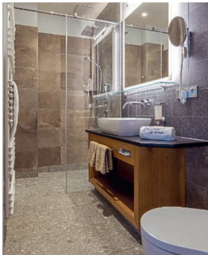
Die Bäder des Viersternehotels Birkenhof Spirit & Spa in Grafenwiesen sind mit geräuscharmen Dusch-WCs von Geberit ausgestattet.
